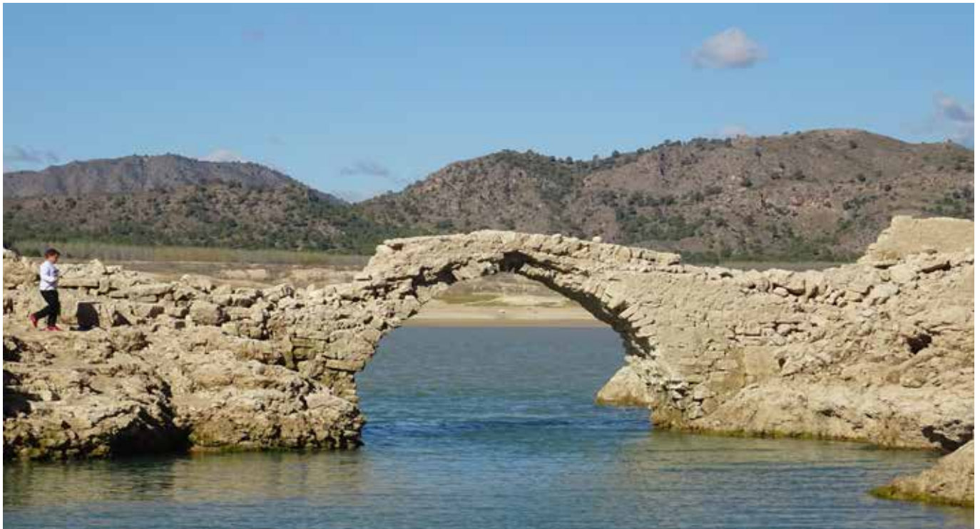
Puente de la Alcantarilla de Jover, también llamado Puente del Diablo en el T.M. de Socovos.
