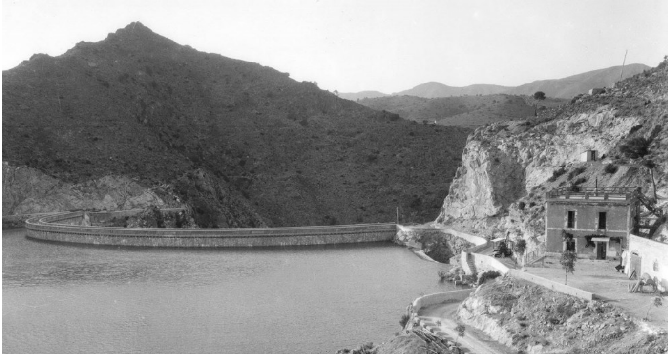
Primer llenado de la presa del embalse de Talave (1918) - Royal
